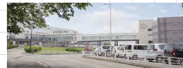
連絡通路で結んだ新外来診療棟と立体駐車場
