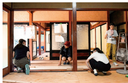
学生シェアハウスの改修
