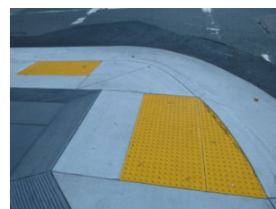
段差がなく視覚障害者にやさしい交差点の歩道
