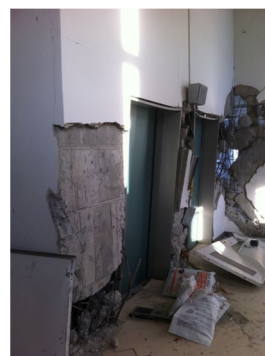
東北大学における被害建物の様子
