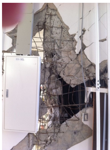
東北大学における被害建物の様子
