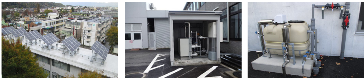
災害対策 プラザ太陽光発電
