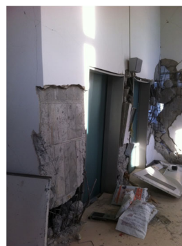
東北大学における被害建物の様子
