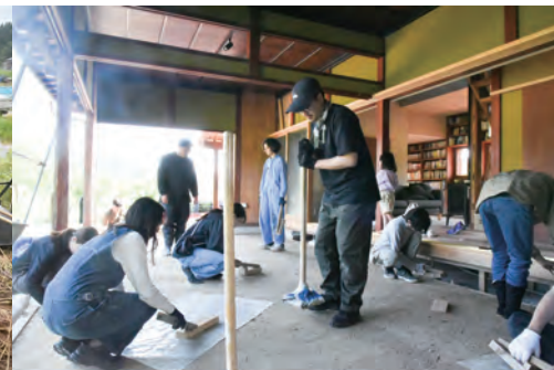
地域の土を使って三和土土間を施工
