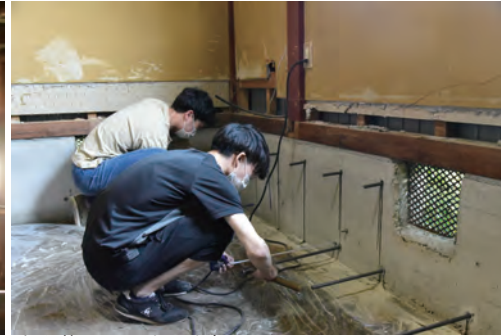
あと施工アンカーを打つ
