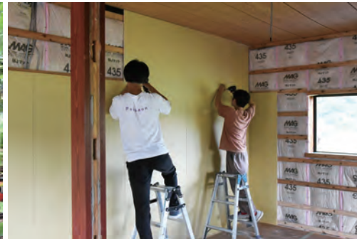
石膏ボードを張る
