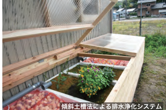
傾斜土槽法による排水浄化システム
