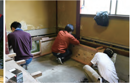
型枠をつくり、基礎コンクリートを増設
