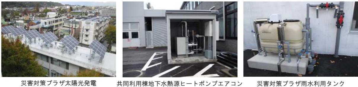
災害対策プラザ太陽光発電
