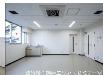
改修後：講座エリア（セミナー室）
