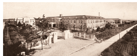
旧制富山高等学校 全景。 現在では取り壊され、馬場記念公園(富山市蓮町)となっている。
