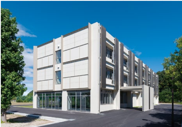
軽金属材料共同研究棟 (Plant Zero)
