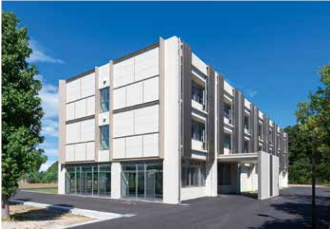
▲ 軽金属材料共同研究棟
