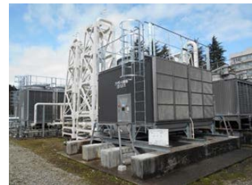
基幹整備（冷凍機設備）
