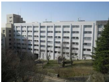
総合研究棟（医学系）改修
