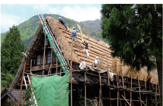
茅葺き屋根の葺き替え作業
